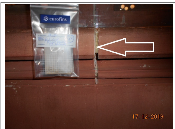
Prélèvement - P17 : TI MULHOUSE / RDC / ENTREE - Joint- (Absence d'amiante)
